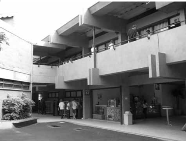
Schulgebäude Block D mit Lanchonete
