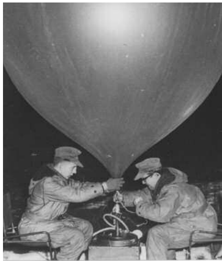
Der fertig befüllte Transport-Ballon hat einen Durchmesser von ca. 2 m
