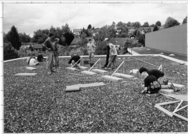
Schüler und Lehrer beim Bau der ersten Photovoltaikanlage
