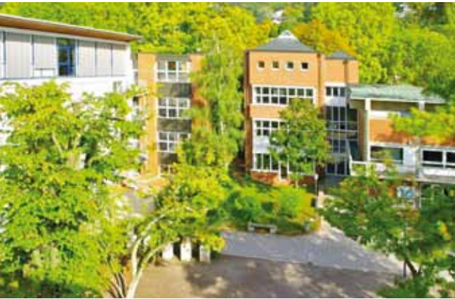
Blick nach Osten vom Schwesternhaus in Richtung Musikturn, Aula und Sporthalle an der Handschuhsheimer Landstraße
